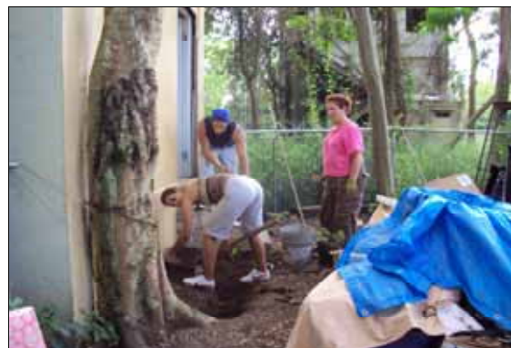
Trabajo voluntario- Pintando para rehabilitar estructura para uso de oficina y siembra de uvas playeras
