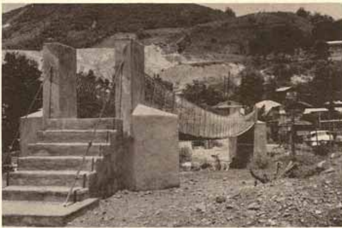
El puente de Mayor Cantera.
