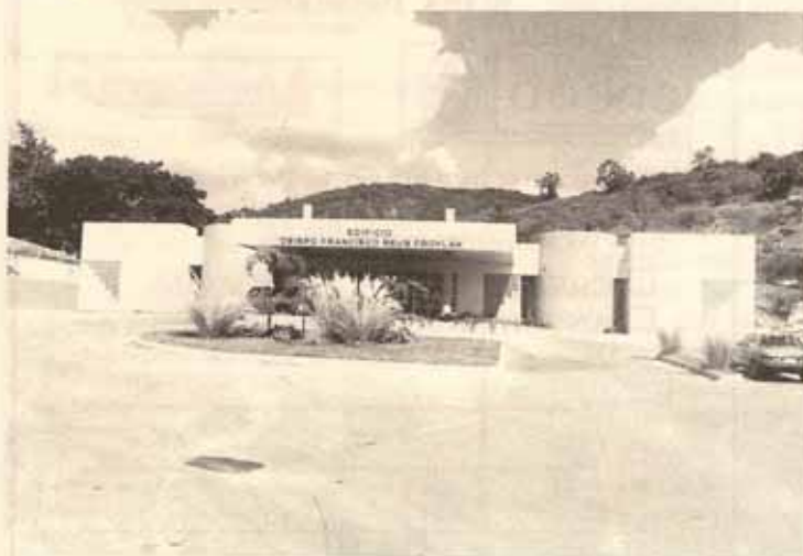
Edificio de cirugía ambulatoria del Hospital Episcopal San Lucas en Ponce, Puerto Rico. Esta nueva sala lleva el nombre del Obispo Francisco Reus Froylán.
