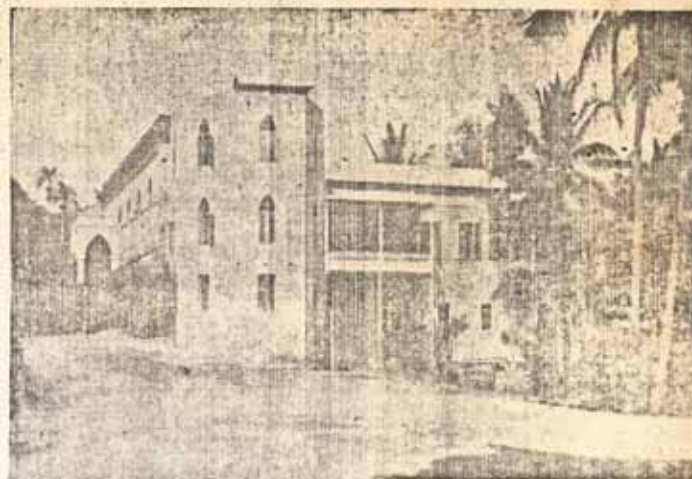
Vista parcial primitiva Iglesia e instalaciones.
