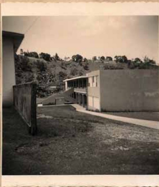
Edificio de salones de clase. ← (por el frente)
