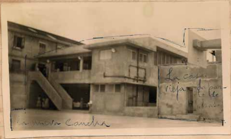
VISTA EXTERIOR DE LOS DOS SALONES Y VISTA PARCIAL DE LA GRAN CANCHA
