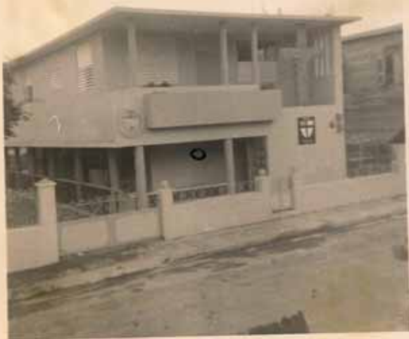
FRENTE DEL EDIFICIO
