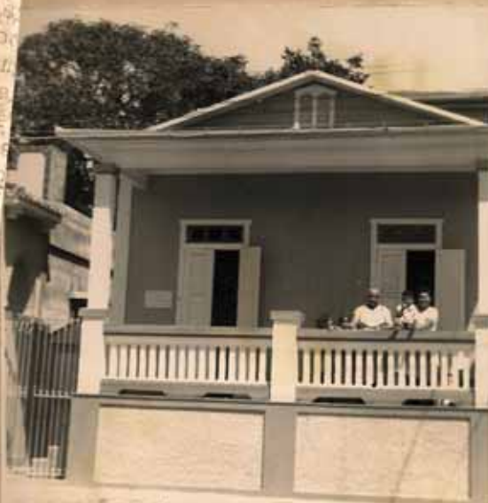
← Calle Trishella n.º 28 Ponce P. R. Calle "Pabellones" →
