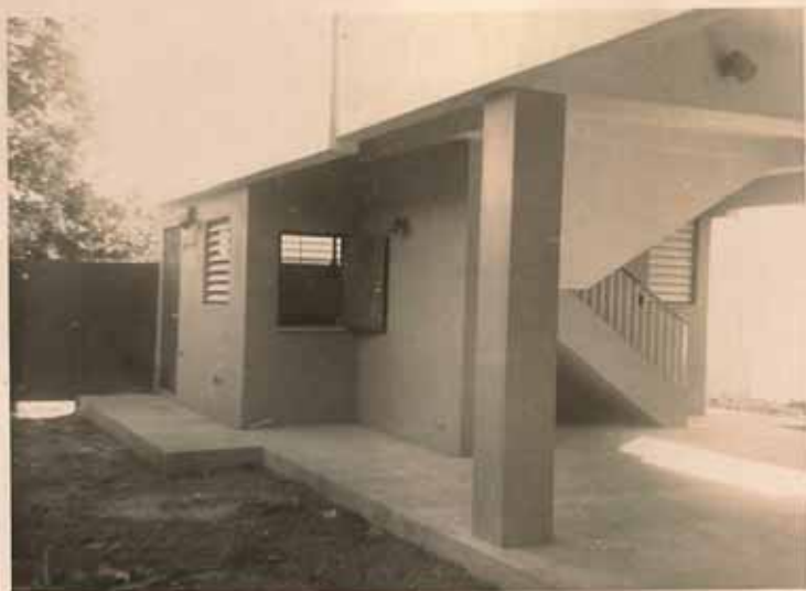
Salón en los bajos
