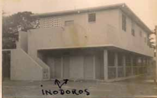
PARTE DE ATRÁS DEL EDIFICIO
